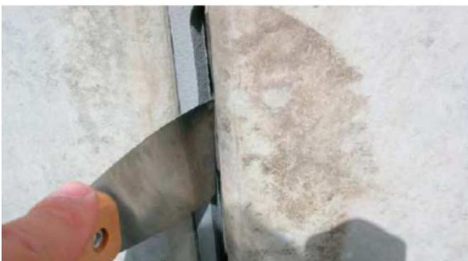
Das Band aus Sicherheitsgründen 2mm von der Fugenvorder/-hinterkante nach innen versetzt verlegen (das Compriband darf nicht bündig mit der Fugenkante abschließen!)
